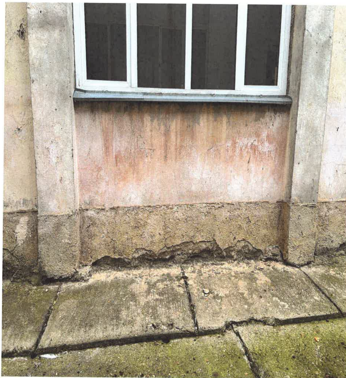
Segment fațadă anterioară
